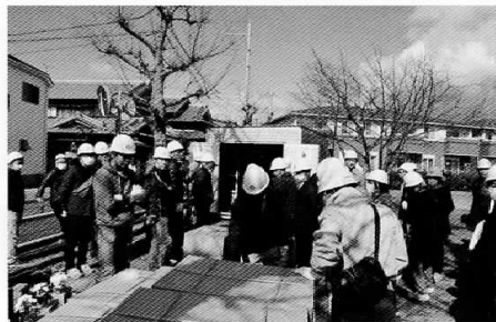
防災倉庫整備点検作業
