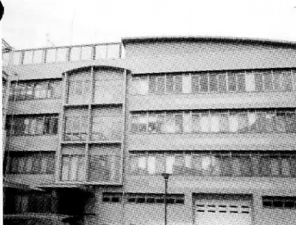
伊勢市防災センターの建物
